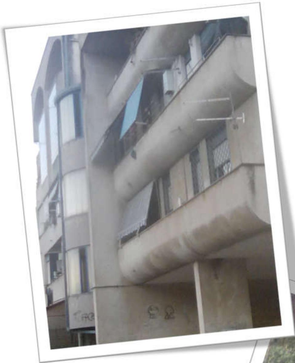
Anche le strutture sembrano provate dalle infiltrazioni di acqua che da decenni si insinuano dal tetto fino a raggiungere i porticati.
